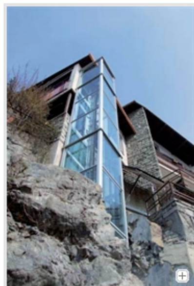
IGVlift. La struttura in alluminio a castelletto, in alternativa al vano in muratura, consente di collocare DomusLift ovunque senza condizionare il contesto architettonico.
